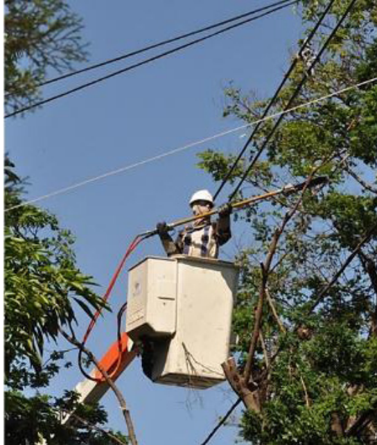
Figura 4: Utilização de Motopoda em cesto aéreo
